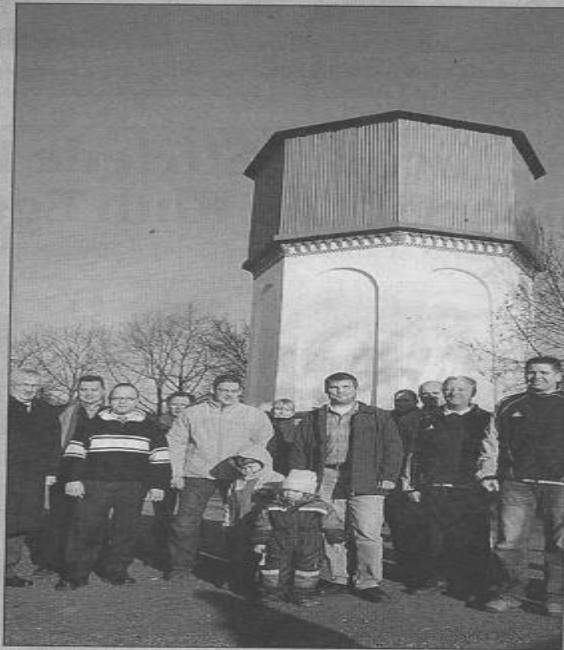
Wasserturm in Ehmen: Stadtwerke und Handballer des HSC Ehmen feierten gestern das Ende der Sanierung. Photowerk (bb)
